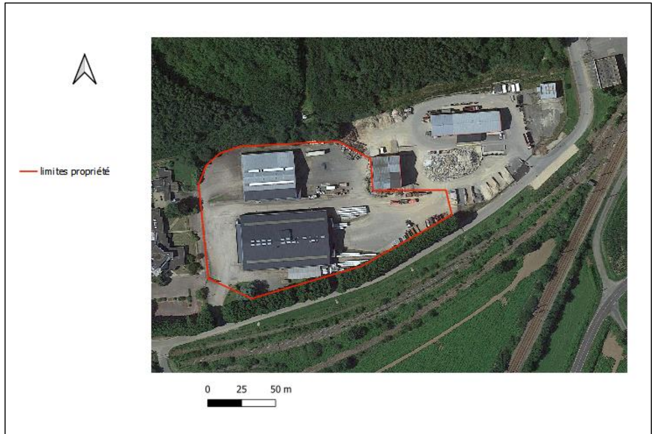
FIGURE 2 : VUE AERIEENNE DU SITE
